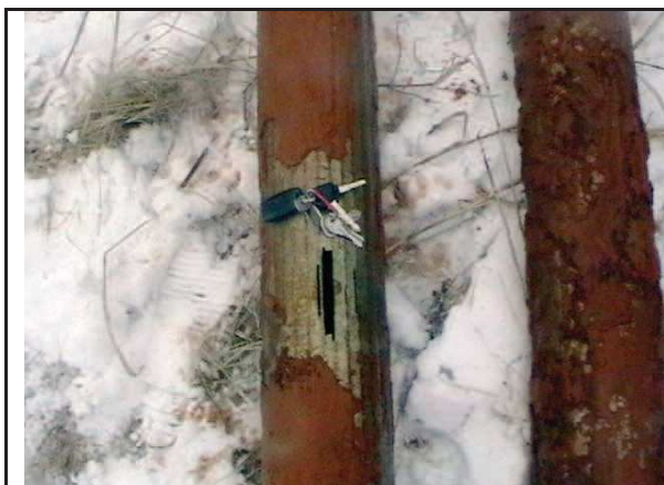
Foto 1: Svislý řez v antikoro zárubnici realizovaný v hloubce 45 m
