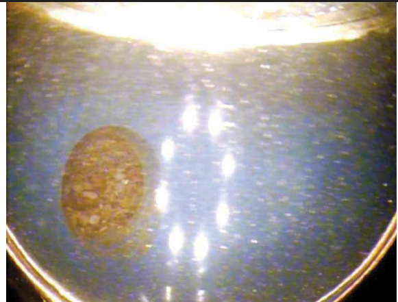
Foto 6: Dosypání vrtu kačírkem, průměr otvoru 52 mm, hloubka 142 m
