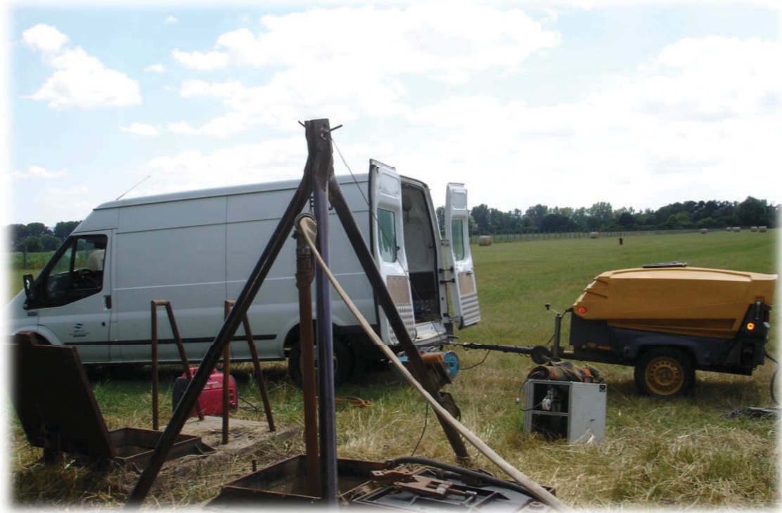
Bzenec (čištění vrtu)
