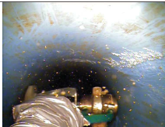
Foto 8: Dosypávání vrtu vnitřkem pažnice, hloubka 142 m
